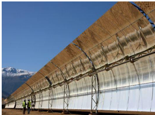
Miroirs cylindro-paraboliques d'Andasol, Espagne
